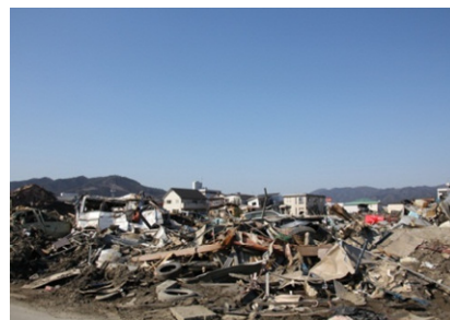
(c) 建物被害の様子 (気仙沼市川口町)
