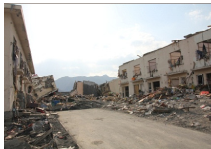
(c) 建物被害の様子 (大槌町新港町)
