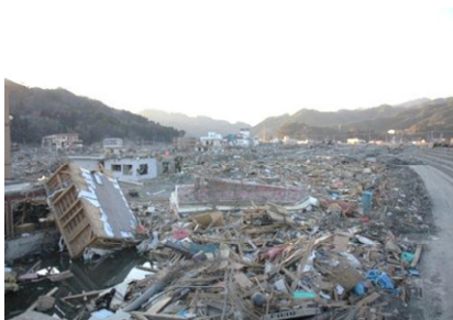
(a) 主要市街地の様子 (大槌川右岸堤防より内陸側を撮影)
