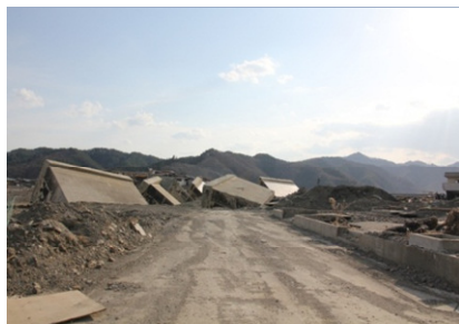
(b) 海岸付近の様子 (大槌港の防潮堤)
