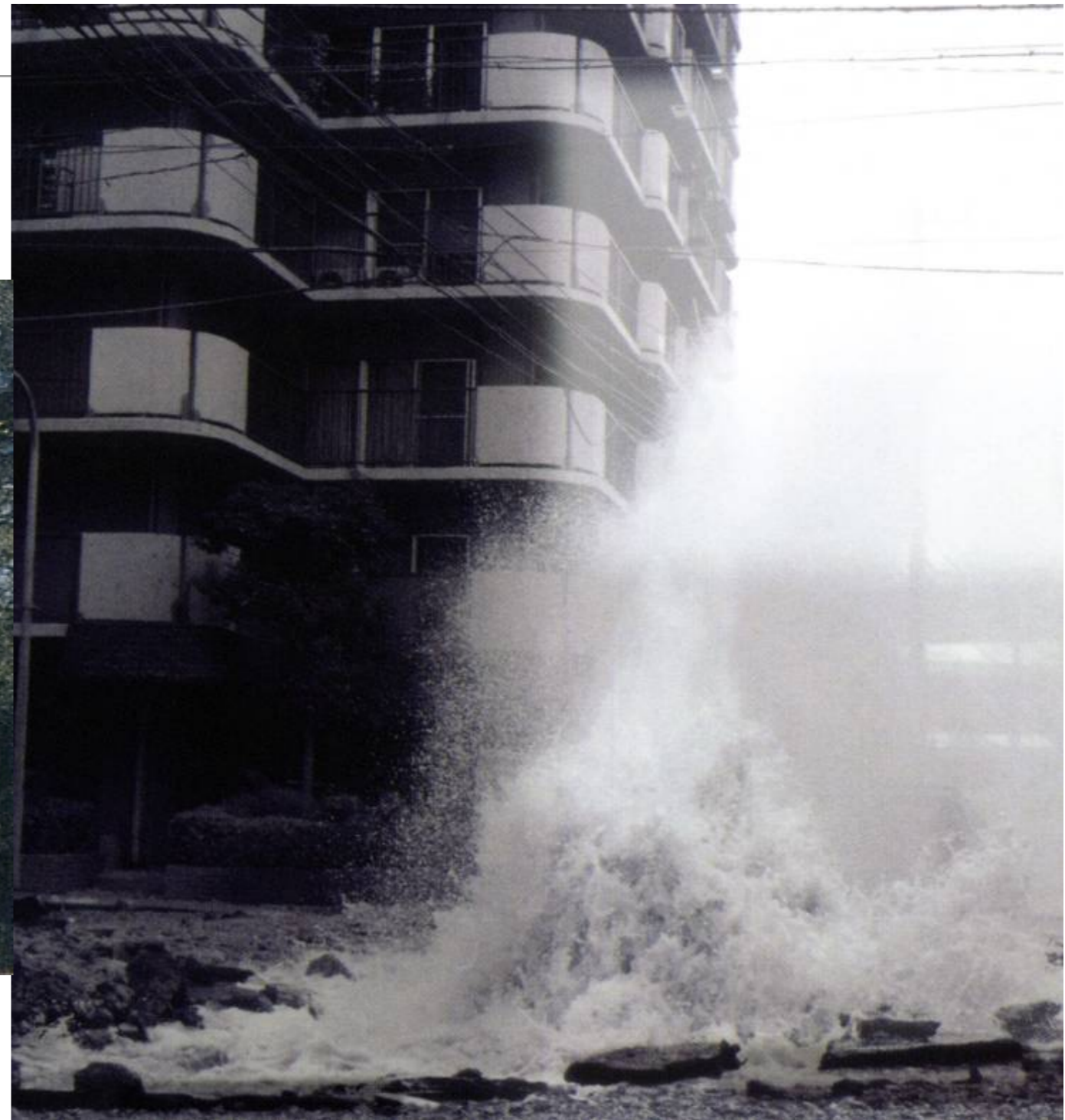
破断箇所からの漏水
