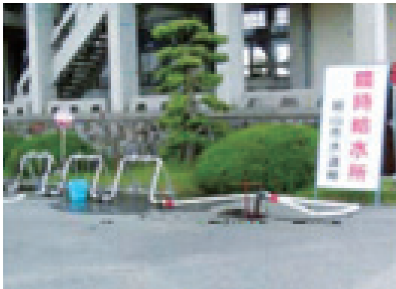
岡山水道局の配水管破裂事故における臨時給水所
