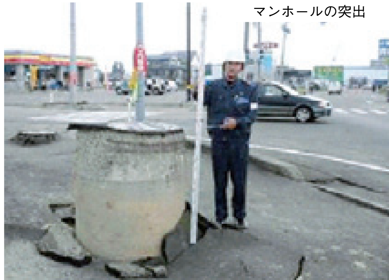
新潟県中越地震における下水道施設の被害状況
