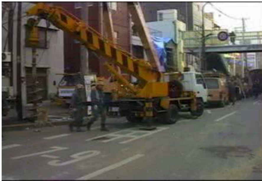
電気復旧工事とがれきの搬出状況
