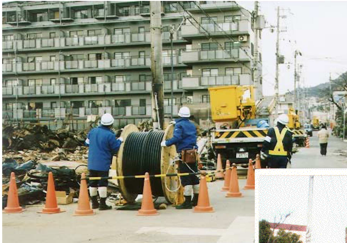
通信ケーブル(架空)の 張り替え
