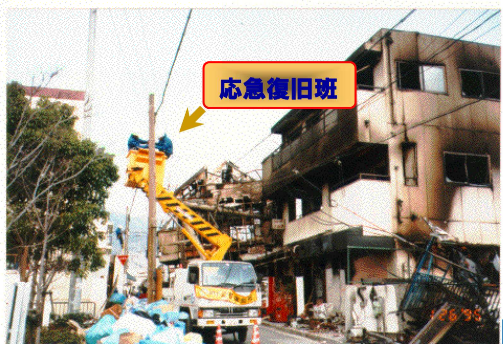
被災をまぬがれた ケーブル心線による応 急復旧
