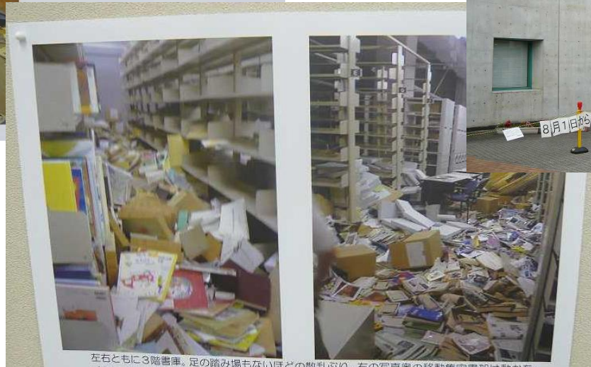
左右ともに3階書庫。足の踏み場もないほどの散乱ぶり。右の写真側の移動棚が倒壊した。
