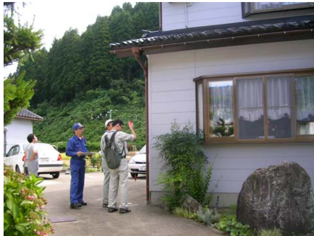
写真2 被害認定調査の状況（柏崎市内）
