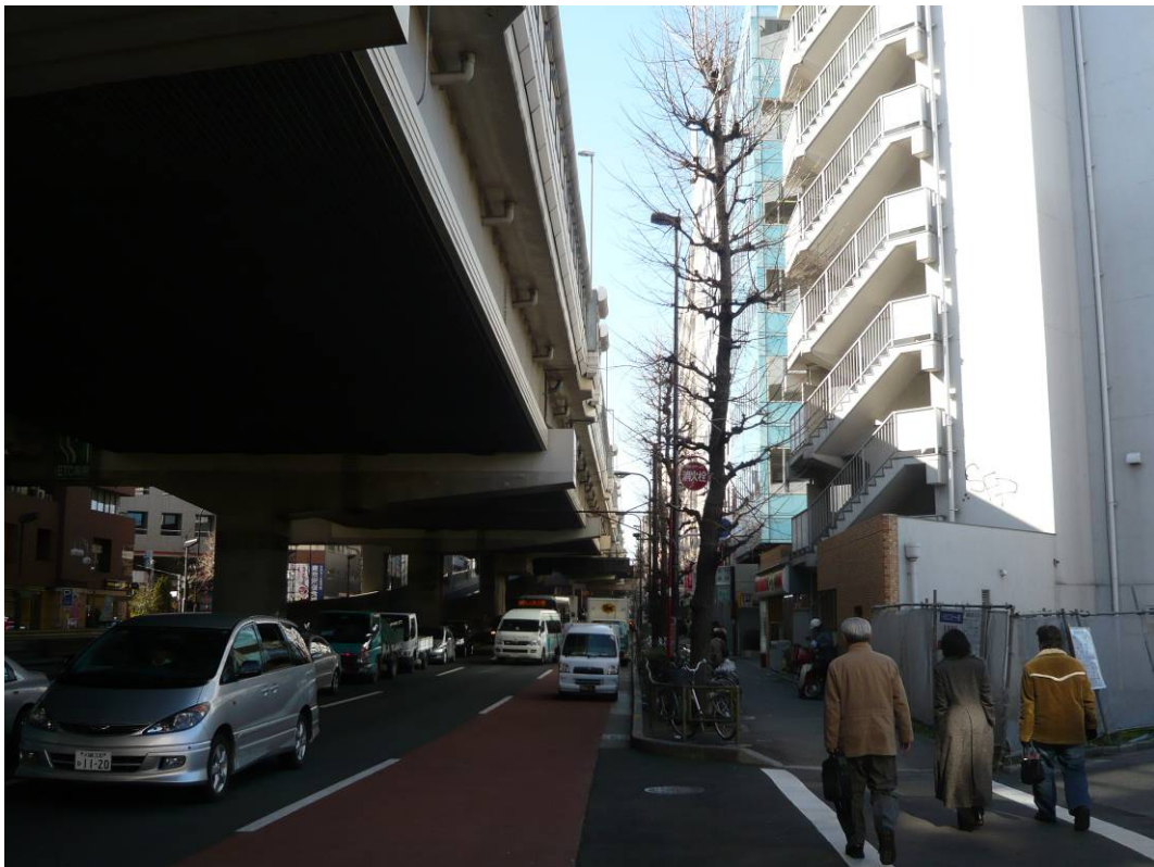
図6 高速道路の高架に隣接する住宅（三宿周辺）
