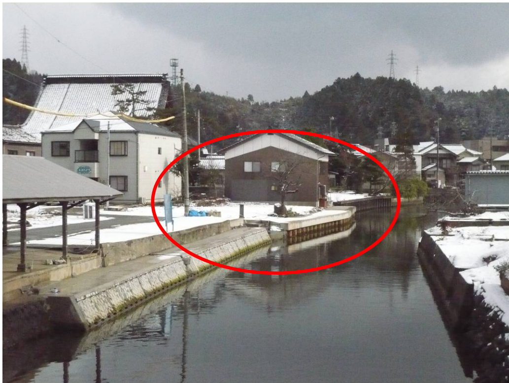
図3 被災した護岸に隣接した住家の再建の事例2 (穴水町：赤丸内が住家のあった箇所)
