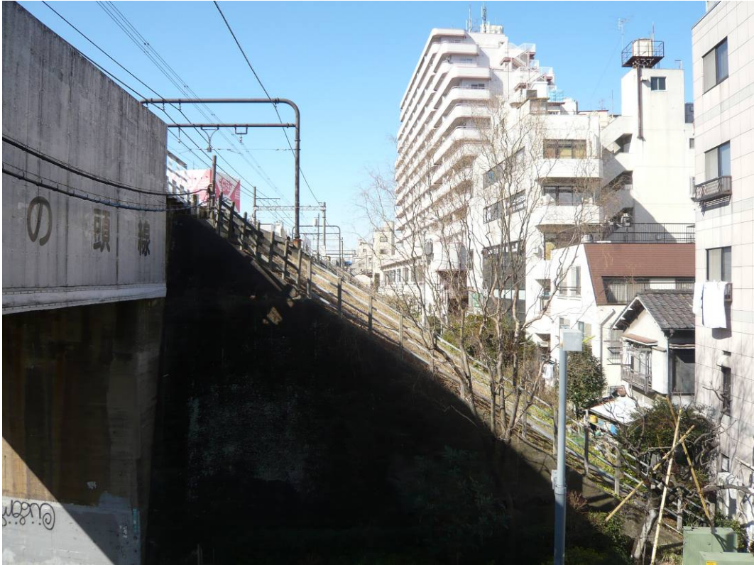
図4 鉄道線路の盛土に隣接する住宅（下北沢駅周辺）
