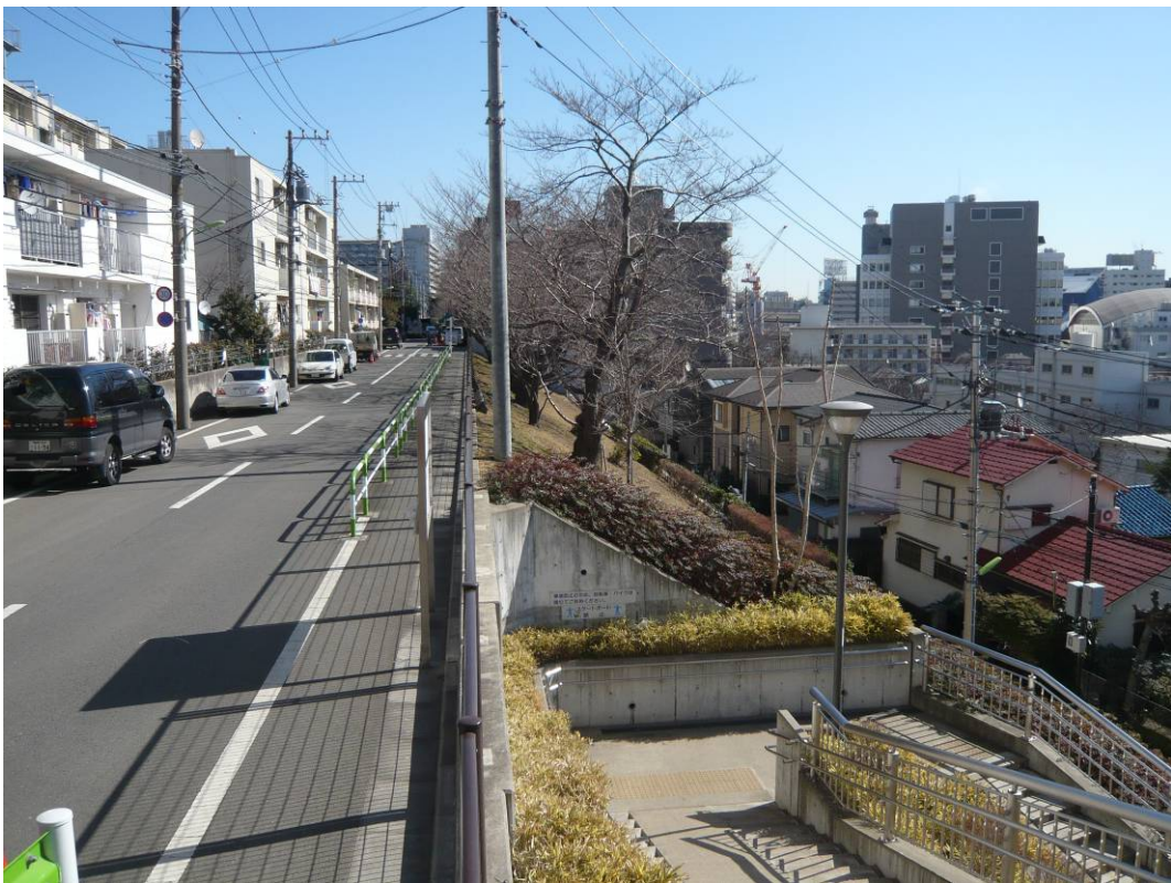
図5 擁壁の上下に隣接する道路と住宅（池尻大橋周辺）
