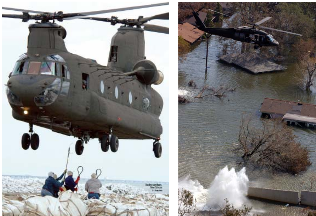
図 3 堤防仮占め作業 12)、13)
