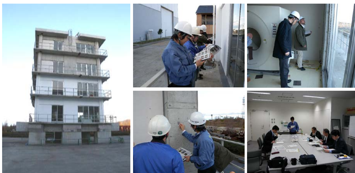
写真3 試験体の建物被害認定調査
