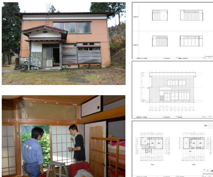
写真1 小千谷市被災住宅の詳細調査と調査結果のデータ化
