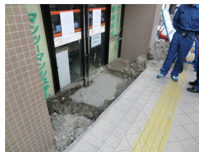
写真4 非木造建物の傾斜と沈下の被害
