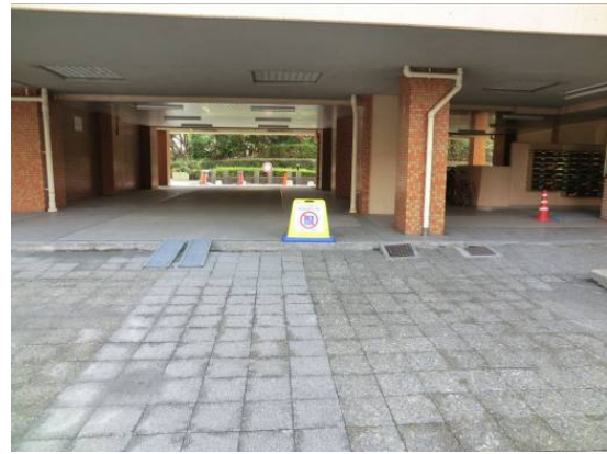
写真3 液状化による大規模集合住宅のエントランス部分の被害
