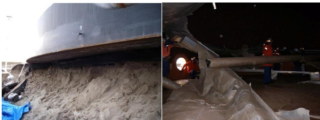
写真3 津波によるタンク基礎の洗堀状況 写真4 内部浮き蓋(アルミ)の破損状況
