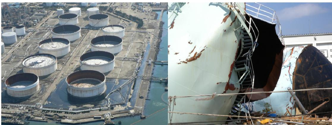
写真1 津波による配管の破損、油流出 写真2 津波によるタンク本体の破損
