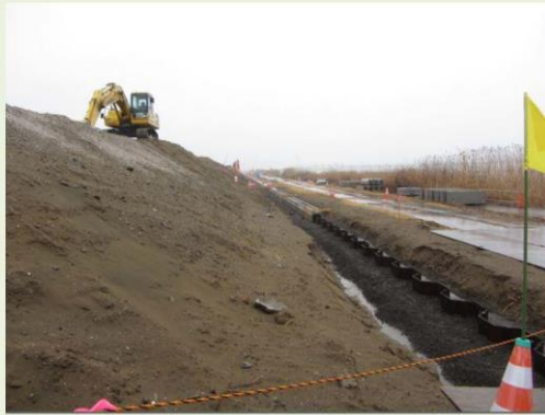
利根川下流香取市石納 鋼矢板での改良(2012. 3. 5)
