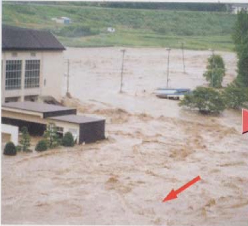
出水状況 (旭町大字 しもぎり 下切)
