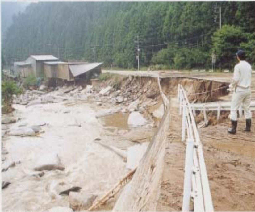
被災状況 (道路崩壊)
