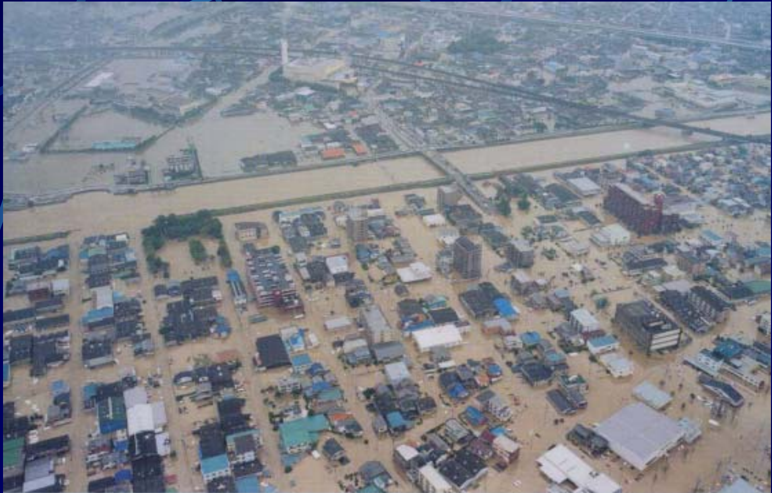
新川浸水状況(名古屋市西区)
