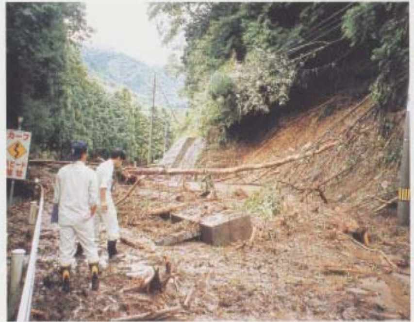
被災状況 (土砂流出)
