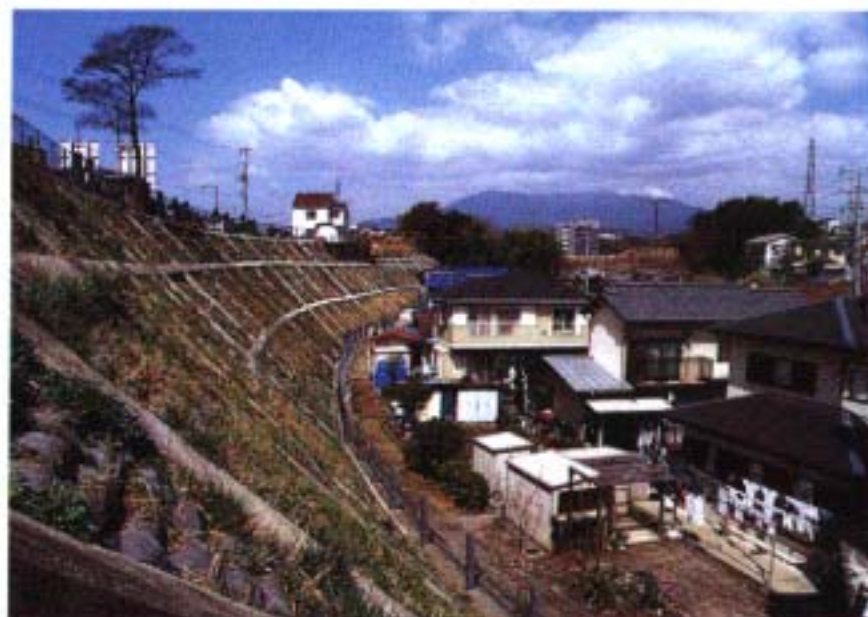
山崩れ等防止工事
