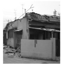
Rd SRd 写真1 甚大な屋根被害の事例
