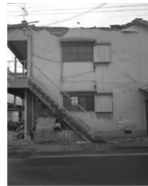
Rd SRd 写真1 甚大な屋根被害の事例
