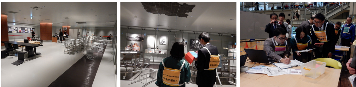
図5 自衛消防隊の安全防護班による建物被害調査
