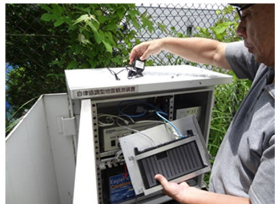
写真 1. 平戸小学校でのルータの電源コード交換実施の様子。
