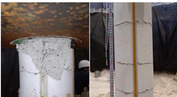
(a) 杭頭損傷状況 (杭 5 東側)
