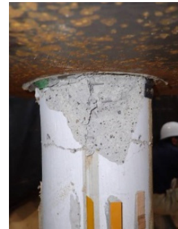
図 12 杭頭部のモルタル圧壊状況
