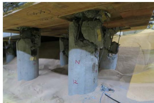
写真3 内山波 300%終了後の杭の損傷状況
